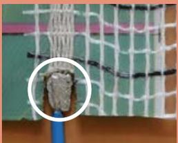
Благодаря применению посеребренной меди присоединение сеточного теплого пола к монтажным проводам возможно с помощью пайки. Используйте низкотемпературный припой ПОС-61
